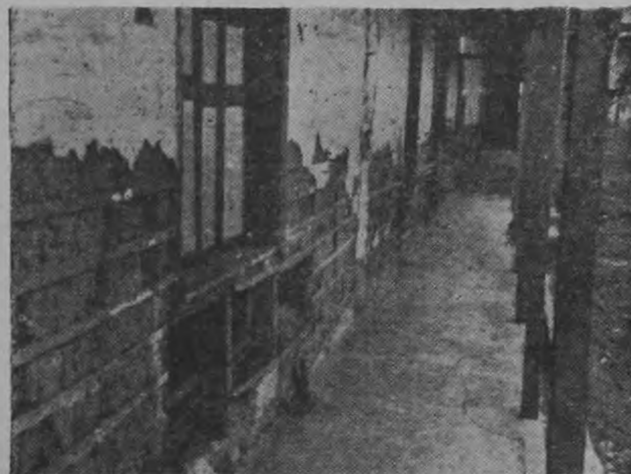
AGUJEROS EN PAREDES QUE SE DESMORONAN.—En la gráfica puede apreciarse una de las paredes de la Escuela Porfirio Brenes Castro, de San Vicente de Moravia. Aulas así han tenido que ser eliminadas, causando un serio perjuicio ya que no resulta suficiente el edificio para albergar al alumnado. La Junta de Educación prohibió que se impartieran las lecciones ante el peligro que representa para los niños el mal estado de la escuela.
